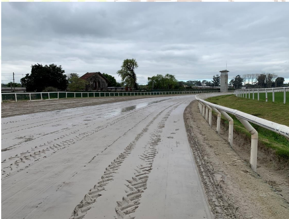
Figura 13: Mantenimiento después de la lluvia (ubicación: 800-1000m)
